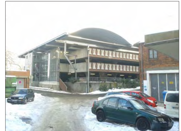
Parkhaus Eisenbahnstraße - Nordzugang. Blick aus Richtung Hertie Anlieferung.
