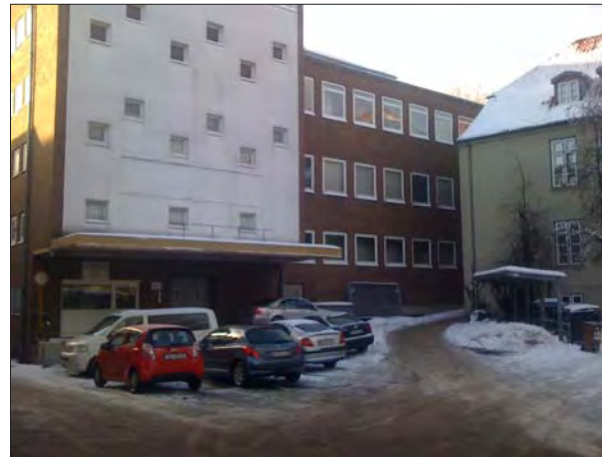
Hertie - Rückwärtige Anlieferung, durch abfallendes Gelände auf UG-Niveau. Blick aus Richtung Parkhaus Eisenbahnstraße/Stegengraben.
