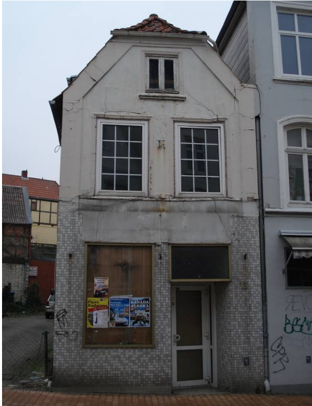
Abb. 22: Gebäude mit hohem Modernisierungs-/ Instandsetzungsbedarf
