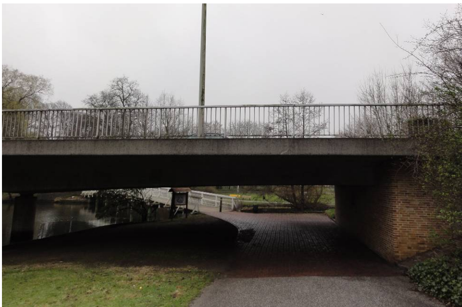
Abb. 39: Fuß- und Radweg Richtung Weiße Brücke
