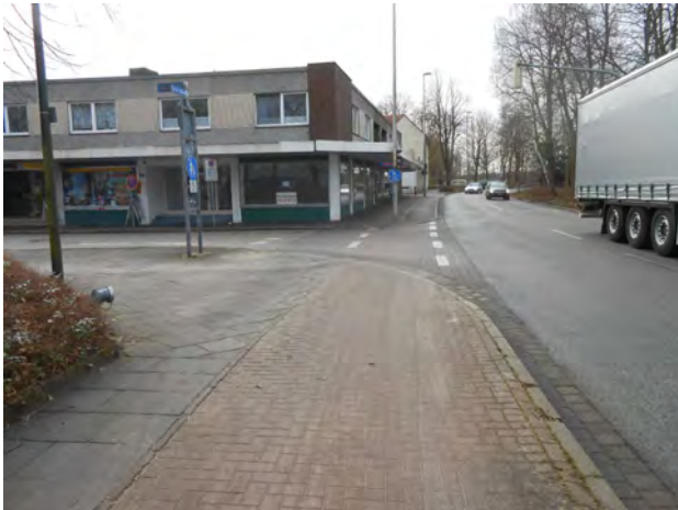
Links: nördliches Ende der Torstraße an der Einmündung In die Straße ‚An der Schleuse‘ Rechts: Westlicher Gehweg Torstraße, der überdachte Bereich liegt auf privater Grundstücksfläche
