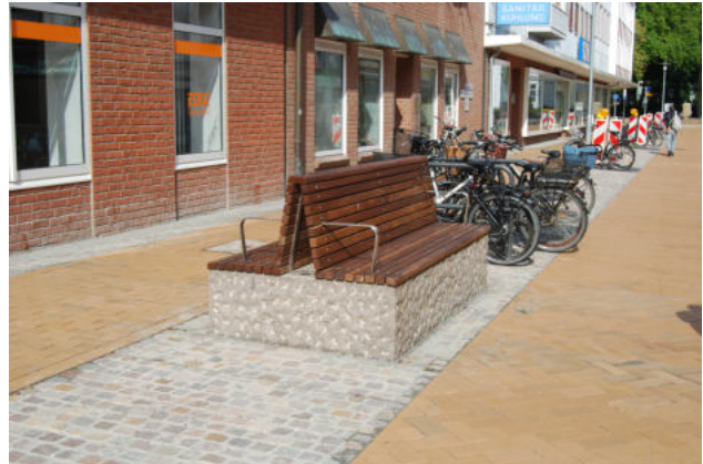
Einbauten Holsteiner Straße
