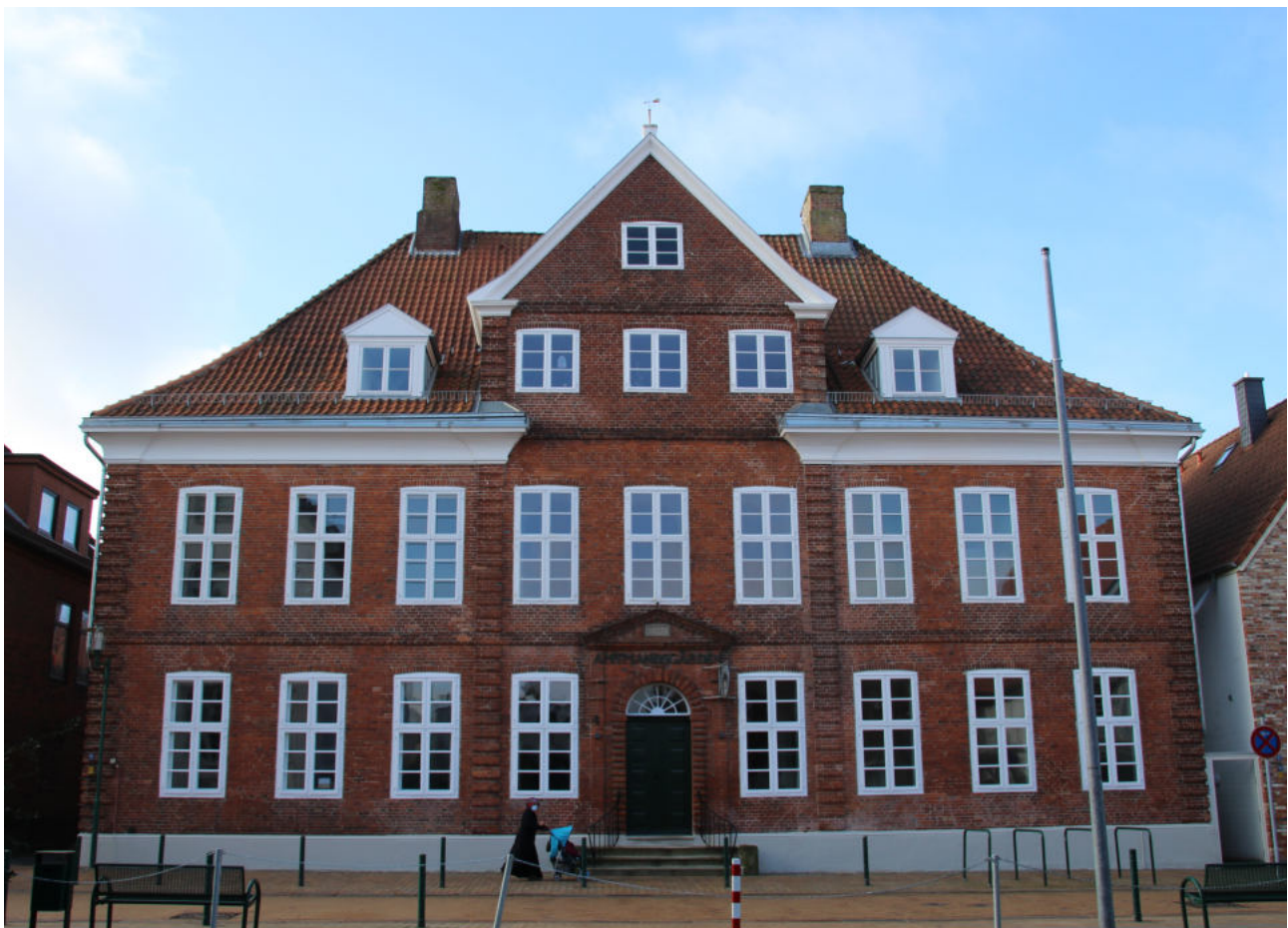
Außenansicht nach der Sanierung
