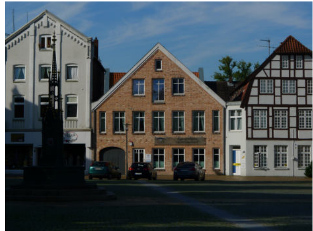
Schloßplatz 3 vor und nach Fertigstellung
