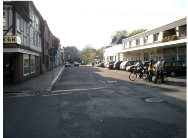
Schleuskuhle vor der Sanierung
