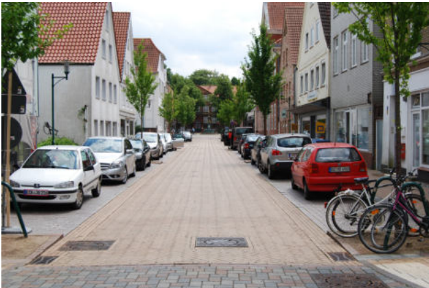
Südliche Torstraße nach der Sanierung
