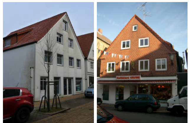
Torstraße 13 vor und nach Fertigstellung
