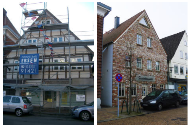
Torstraße 5 vor und nach Fertigstellung
