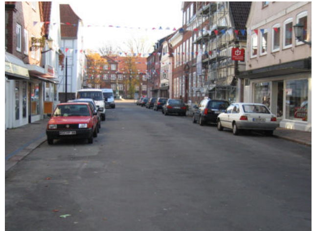
Südliche Torstraße vor der Sanierung
