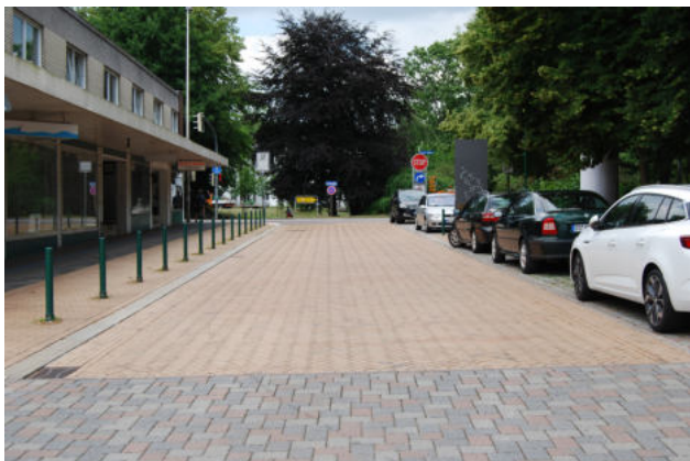
Nördliche Torstraße nach der Sanierung
