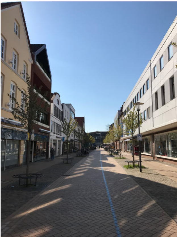
Gestaltung Holsteiner Straße nach dem Ausbau
