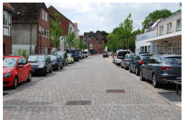
Schleuskuhle nach der Sanierung
