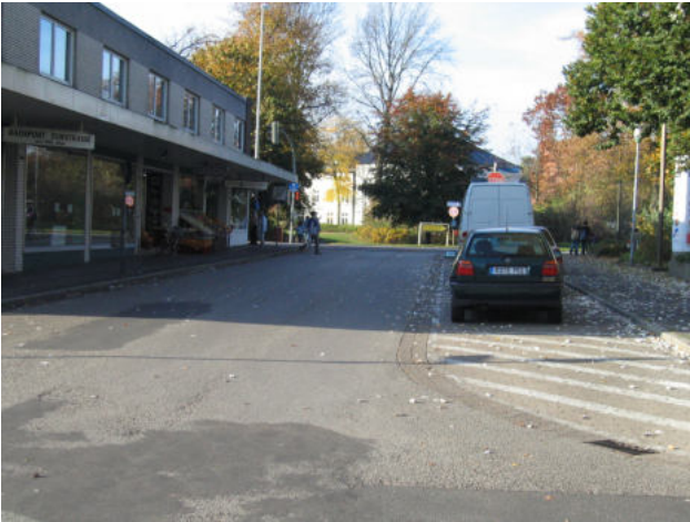
Nördliche Torstraße vor der Sanierung
