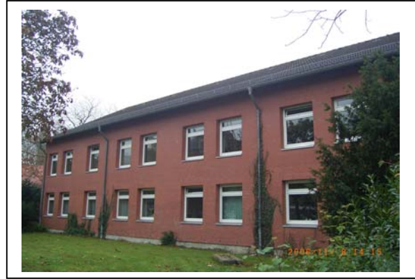
Abbildung 23: VBK Gebäude Nr. 25
