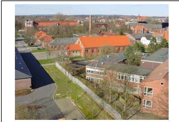
Abbildung 8: Denkmalgeschützter Gebäudebestand und Helene-Lange-Gymnasium (Vordergrund)
