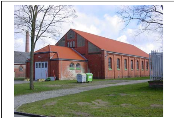
Abbildung 20: ehemalige Reithalle (Gebäude 20)
