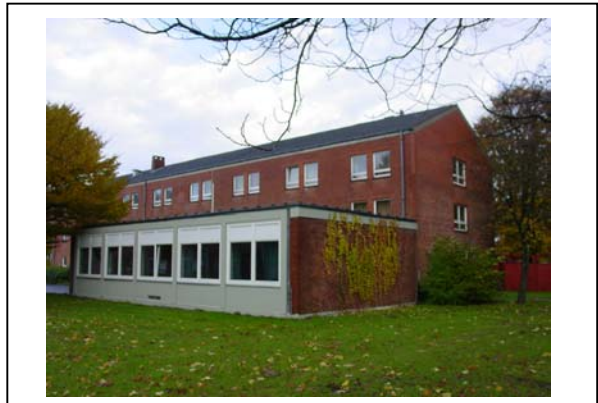
Abbildung 13: Unterkunft- u. Schulungsgebäude (Nr. 31 / 31a)
