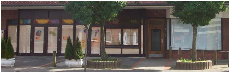
Bestandsfoto Leerstand ehem. Kino, ehem. Lebensmittel-Discounter und ehem. Eisdielen
