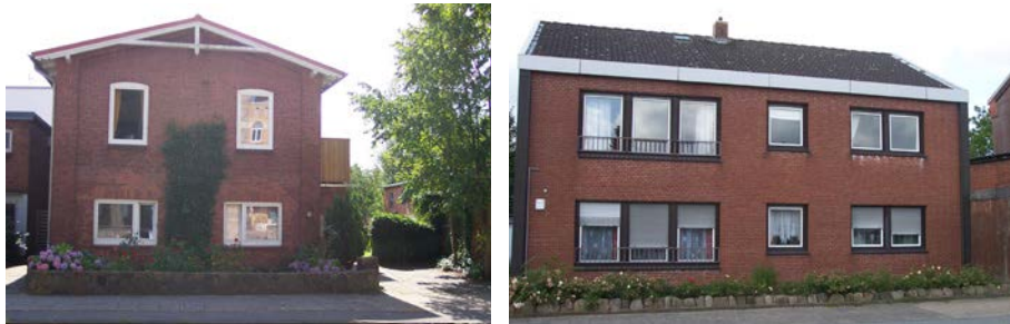
Bestandsfotos Wohnen in den Erdgeschossen, Eckernförder Str. 41 und Hollerstr. 37
