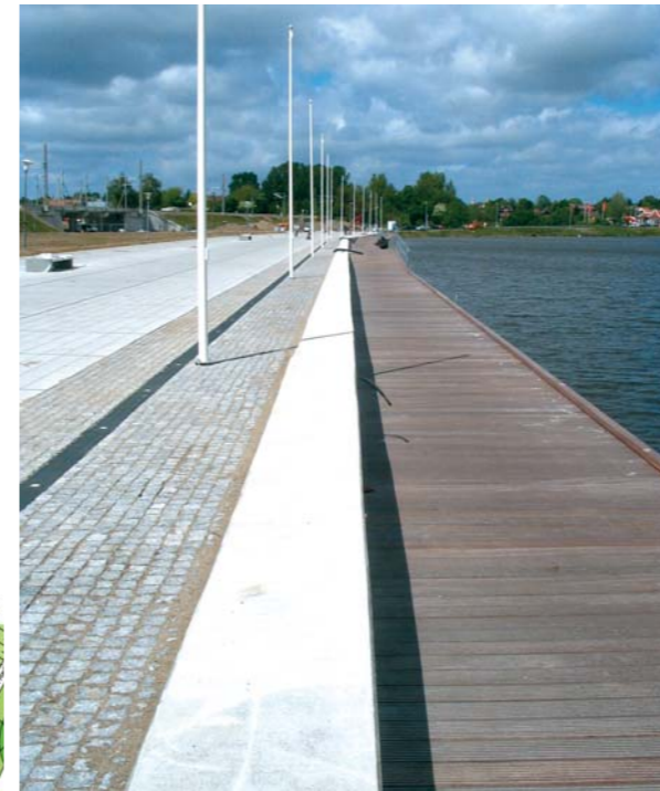
Die neue Hafenpromenade nach dem Ausbau
