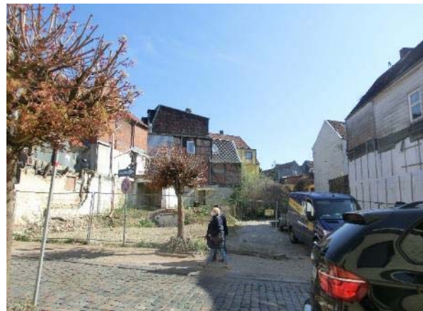
Abb. 12: Schleifmühlenstraße 11 bis 13, freigelegte Grundstücke (© ELBBERG Stadt Landschaft 2021)
