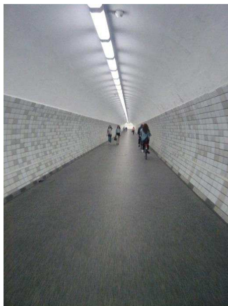
Abbildung 35: Fuß- und Radtunnel Quelle: eigenes Foto
