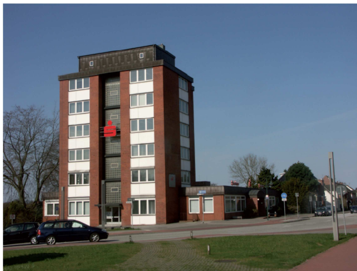
Abb. 1: Gebäude vor Sanierung
