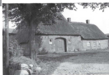
Abb. 11: Hofstelle Drews, Neue Dorfstraße
