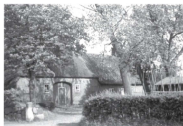
Abb. 9: Hofstelle Drews, Neue Dorfstraße
