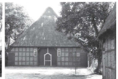
Abb. 10: Hofstelle Harder, Neue Dorfstraße
